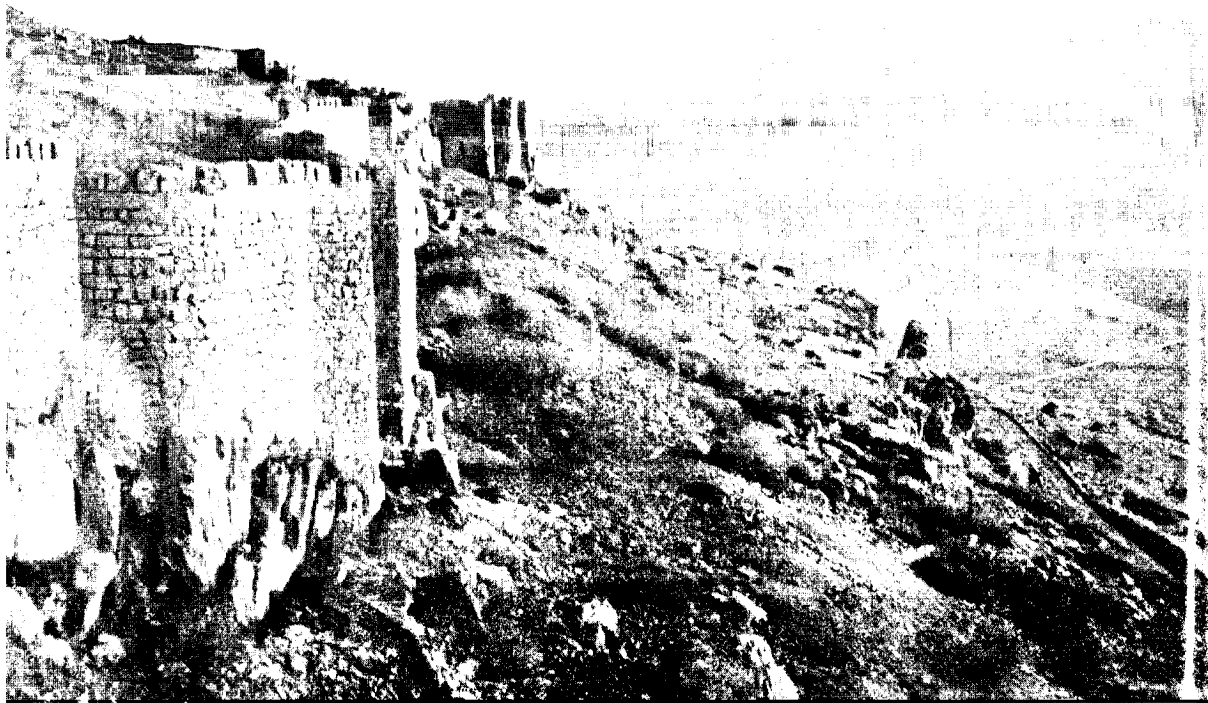
4.—Sacro Convento de Calatrava la Nueva, Muralla exterior de Poniente.
