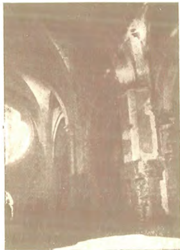
Interior de la iglesia.
